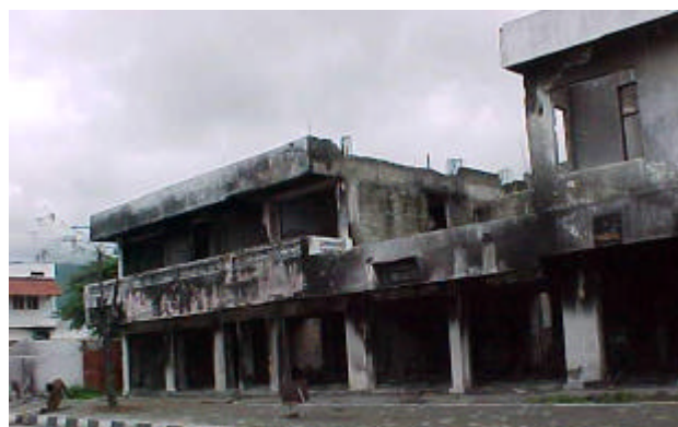
Förstörda byggnader i Dili
